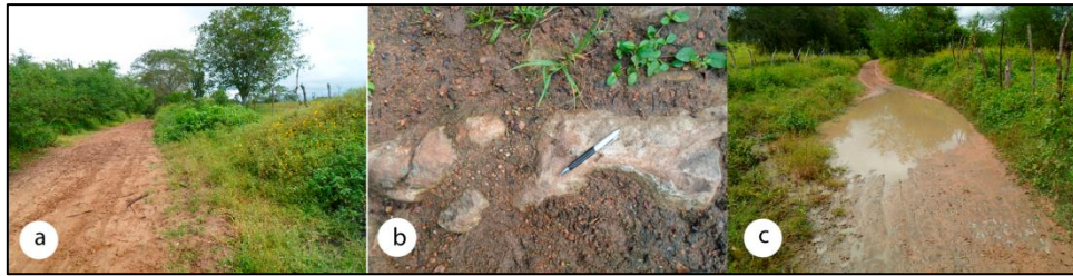
Figura 2. a) Presença da vegetação invadindo a estrada; b) Afloramento de rocha, muito característico nessa estrada; c) Poças d'água, devido a pequenas depressões, causadas pela precária manutenção.
