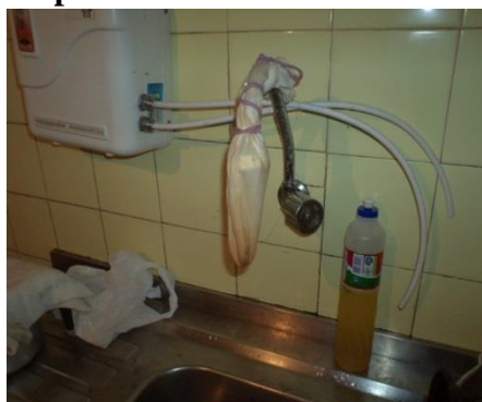
Figura II: Filtro improvisado em uma das residências estudadas.
