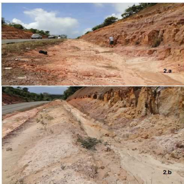
Figura 2. a – Vista do afloramento B (24L 0613810; UTM 88622638). b – Canaleta proveniente da contenção tipo: Berma/canaleta.
