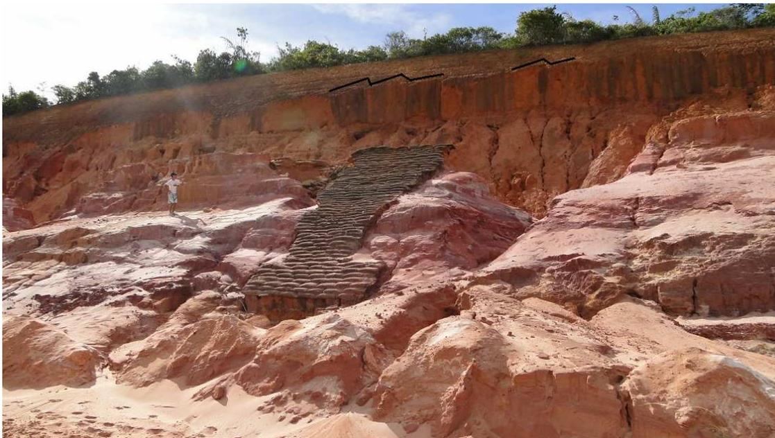
Figura 3 – Forma de como se dá o desprendimento de bloco em encostas que bordejam a rodovia BA-099.
