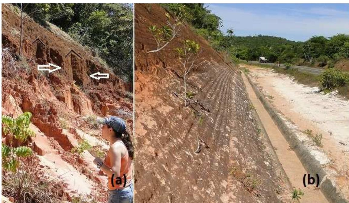
Figura 4 – Alta densidade de juntas na encosta (a) comparando com a baixa densidade da encosta (b).
