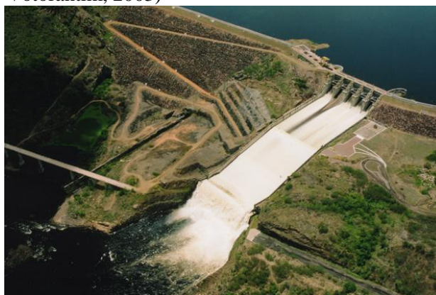
Figura 2 – Usina Hidrelétrica Pedra do Cavalo:
