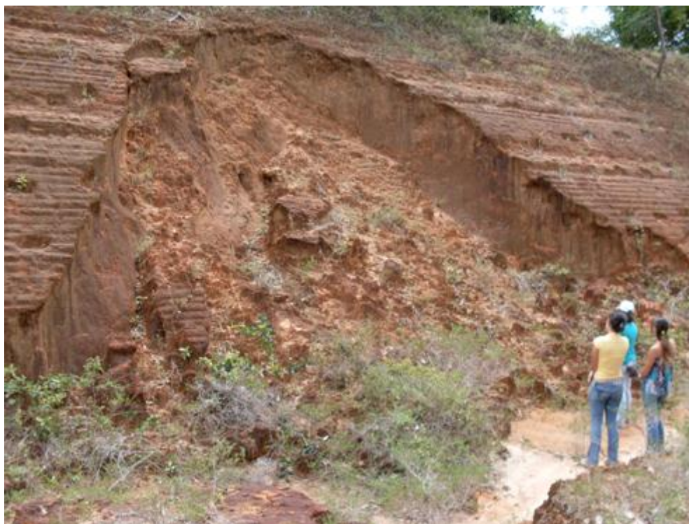
FIGURA 2 – Deslizamento rotacional. Fonte: autor (2009)
